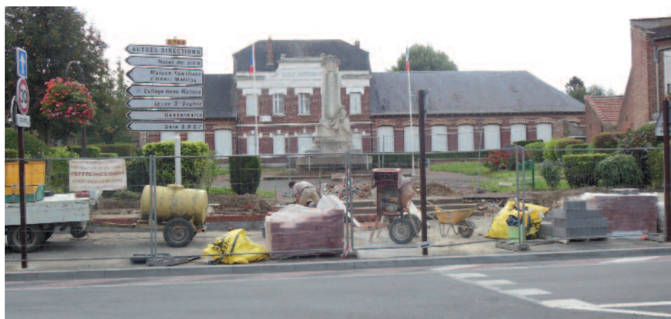
Le monument aux morts pendant les travaux
