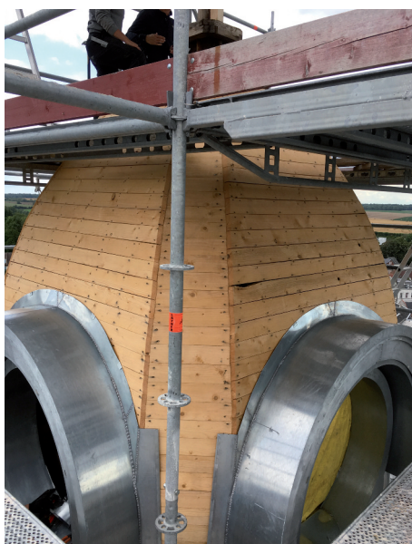
Charpente du clocher
