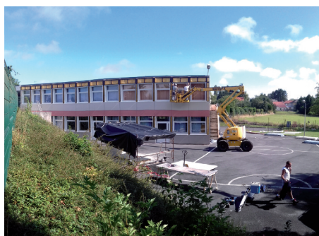
Façade de l'école des Torrents
